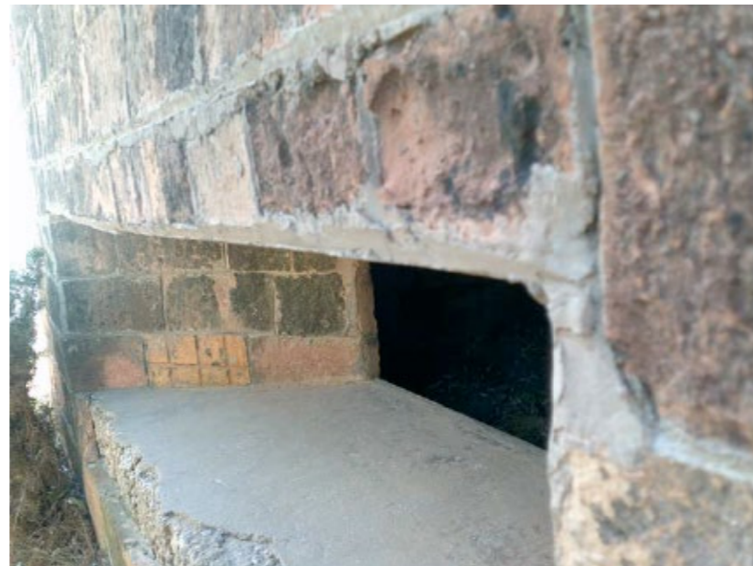
DETALL DE L'ENCOFRAT CERÀMIC.
