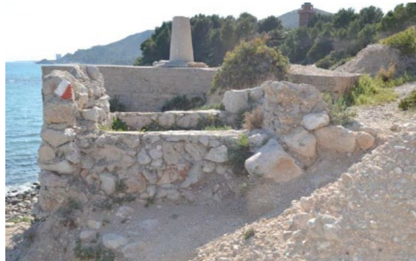
VISTA DE LA PARET LATERAL DE LA PEÇA.
