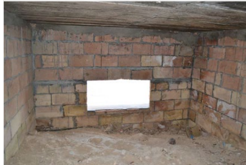
VISTA DE L'INTERIOR DE LA PEÇA.
