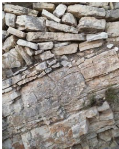
DETALL DEL MUR DE CONTENCIÓ DE PEDRA SECA.
