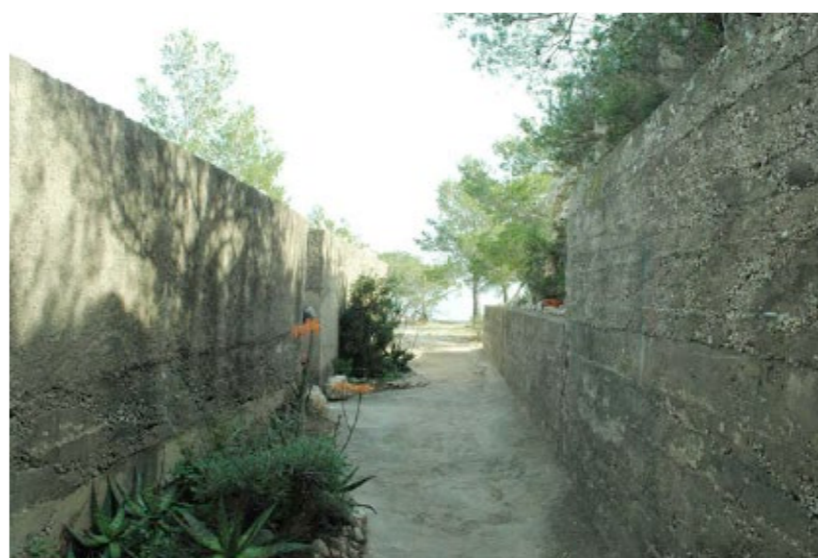
VISTA DEL PASSADÍS D'ACCÉS AL POLVORI.
