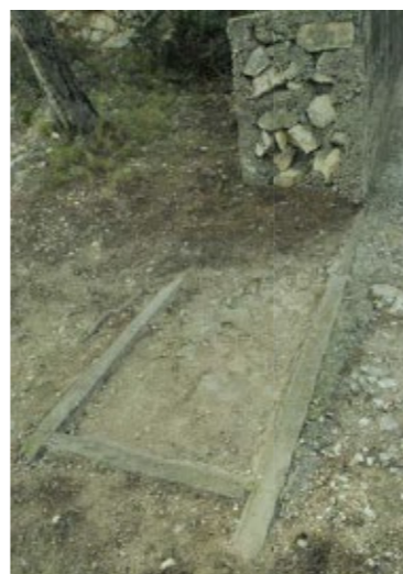
DETALL DEL MUR A MITJA CONSTRUCCIÓ.
