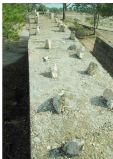
DETALL DE LES ESPERES DE LA CONSTRUCCIÓ.
