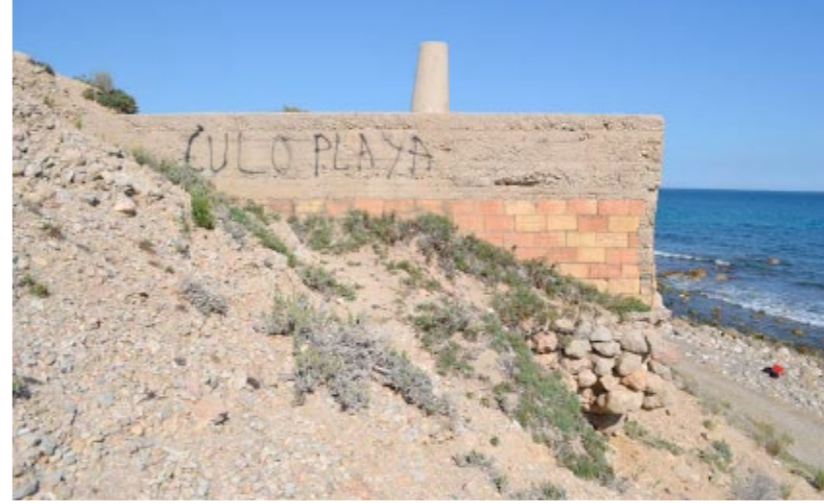
VISTA DEL LATERAL SUD-OEST DEL FORTÍ.
