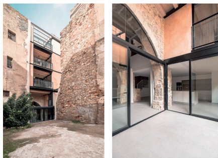
REHABILITACIÓ DE L'EDIFICI PER A DESTINAR-LO A VUIT HABITATGES » TARRAGONA
